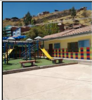
FOTOGRAFIA N° 03: INSTALACION DE COBERTURA DE MALLA RASCHELL
