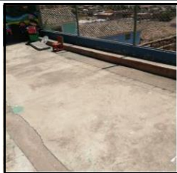
FOTOGRAFIA N° 01: MANTENIMIENTO DE PISO DE LOSA DE CONCRETO
