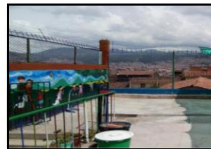
FOTOGRAFIA N° 02: MANTENIMIENTO DE MALLA DE ACERO - CERCO
